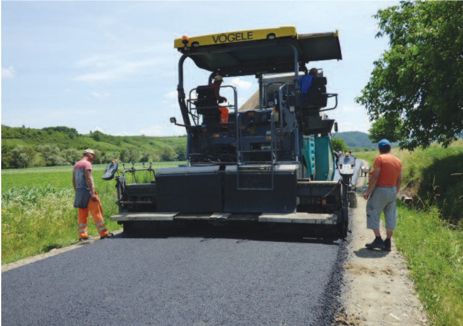
Ebben a hónapban befejezik a 7,5 kilométer aszfaltszőnyeg építését
